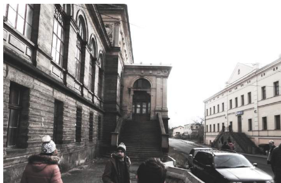
PROSTOR MEZI SEVERNÍ A JIŽNÍ BUDOVOU
