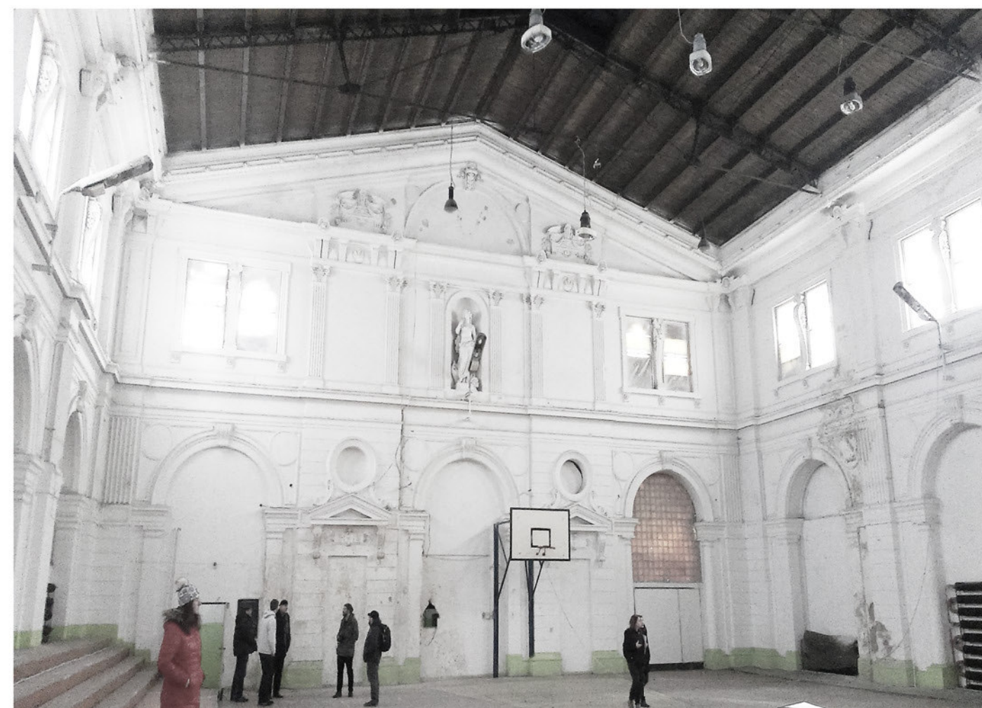
FOTOGRAFIE STÁVAJÍCÍHO STAVU
