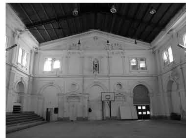
Fotografie současného stavu
