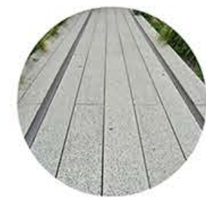
6. Zapuštěné koleje do dlažby
