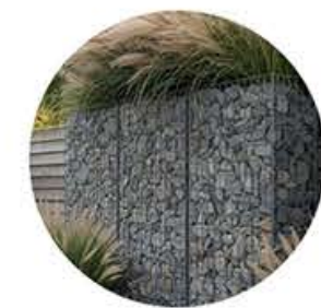
8. zeď z gabionových košů
